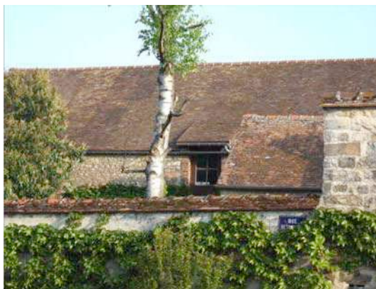
Toiture en tuiles plates sur un corps de ferme traditionnel
