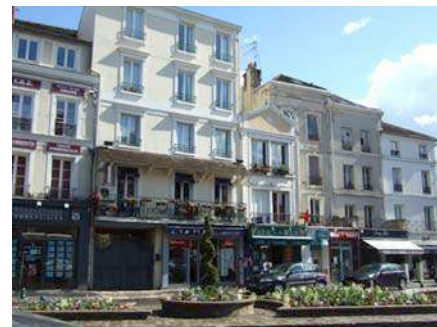
Le gabarit des bâtiments atteint facilement R+4 (ci-dessus et ci-dessous)
