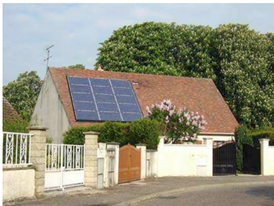
Toiture intégrant un dispositif de capteurs solaires
