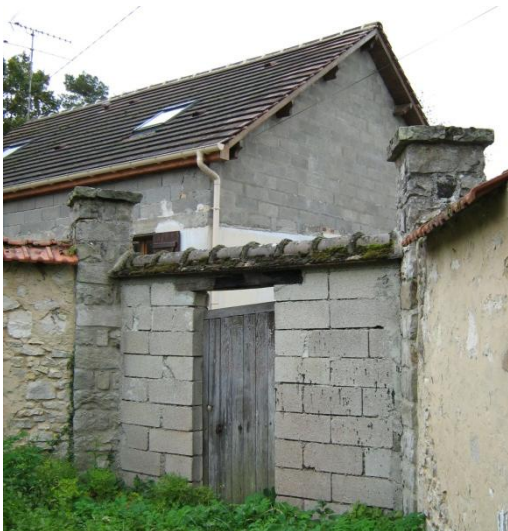
Exemple de maçonnerie apparente proscrite
