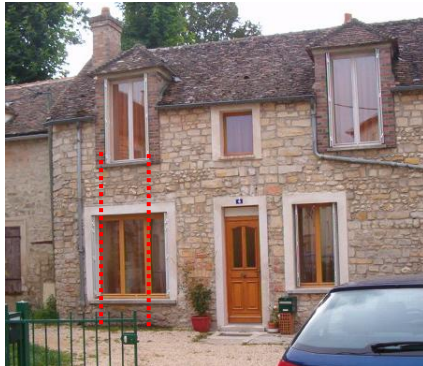
Exemple de fenêtre ne respectant pas les percements initiaux de la construction
