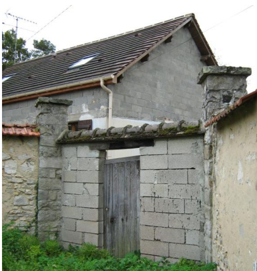
Exemple de maçonnerie apparente proscrite
