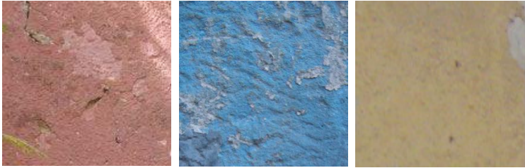
Exemple d'enduits traditionnels anciens relevés sur la commune
