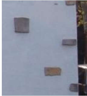
Exemple d'insertion de pierres dans l'enduit interdite
