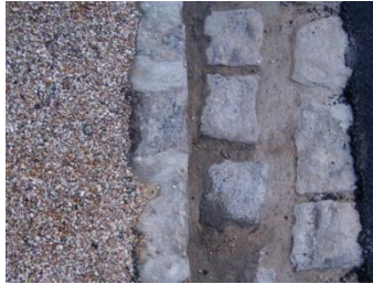
Chaille, pavé de grés et sable stabilisé comme référence pour le traitement des sols.
