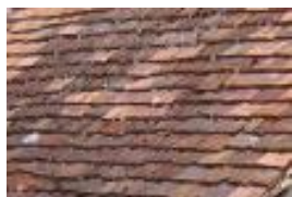
La tuile plate petit moule en terre cuite, une référence pour les toitures de la commune
