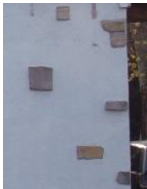
Exemple d'insertion de pierres dans l'enduit interdite
