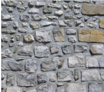
Exemple de jointoiment d'une maçonnerie ancienne en creux et au ciment interdit
