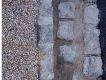
Chaille, pavé de grès et sable stabilisé comme référence pour le traitement des sols.
