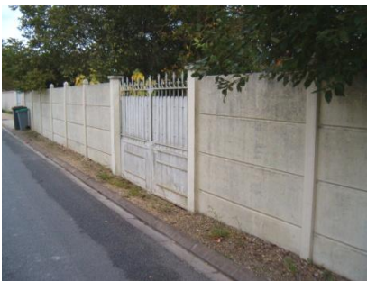
Exemple de clôture en plaques de béton (palplanches) interdite
