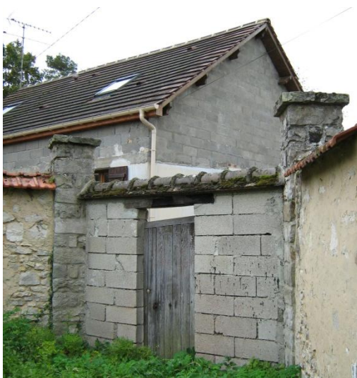
Exemple de maçonnerie apparente proscrite
