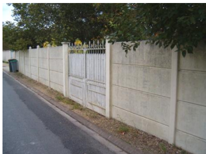
Exemple de clôture en plaques de béton (palanches) interdite
