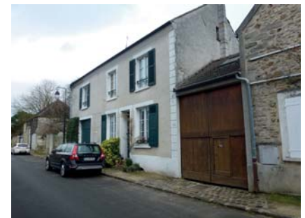
Une maison rurale dans le bourg.
