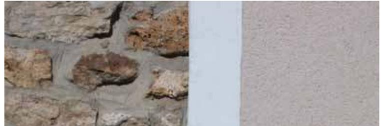
*Nota : Aussi bien en rénovation qu'en construction écologique, les enduits à la chaux favorisent la qualité de l'air intérieur du bâti en laissant migrer la vapeur d'eau à travers les murs.*
