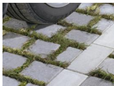
Pavés à joints enherbés
