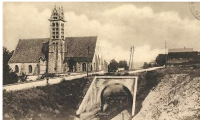
L'église et le pont de chemin de fer
