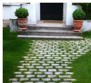
Pavés à joints enherbés
