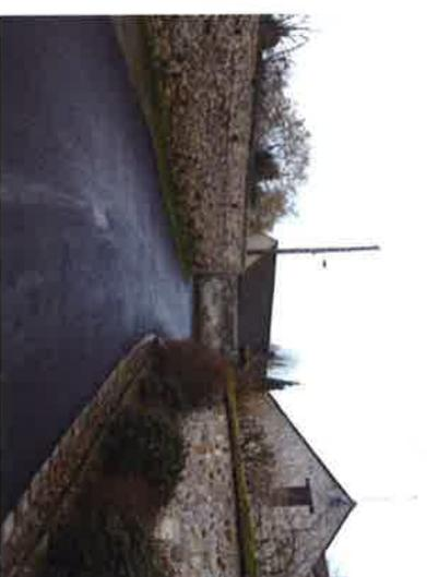
La maison de bourg est caractéristique de l'ossature du village proche du château, avec des façades et des toitures discontinues (faîçage et inclinaison). Les façades sont en pierres, moellons de meuliers et de grès jointoyés au mortier de chaux. Les toitures à deux pans sont couvertes de tuiles plates anciennes. Les murs ont une fonction très importante : ils permettent de relier les maisons entre elles et de créer un front bâti continu.
