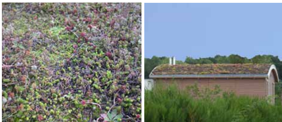
Toit végétalisé sur une maison d'habitation contemporaine.
