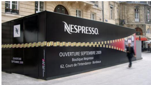
Publicité sur palissade de chantier
