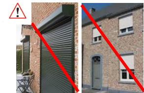
Les volets roulants sont une technologie récente, ils ne sont pas adaptés aux constructions anciennes et ne s'intègrent pas au dessin de la façade.
