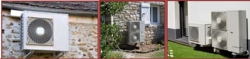
Dispositifs techniques dévalorisants, à disposer côté non visible et à habiller
