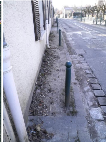
Trottoir étroit le long de la RD64
