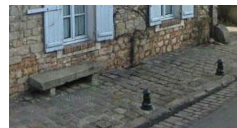
Ensemble d'éléments mobiliers anciens à préserver (bancs de grès, pare-roue, bordure et pavage du trottoir, plantation en pied de façade, etc.) au droit de l'Auberge Ganne.
