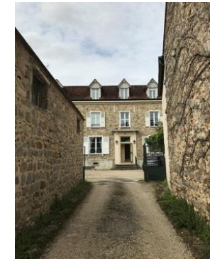
Bâti de second rang et venelle d'accès à la cour intérieure
