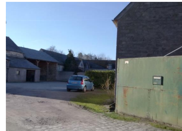
Accès et cour de la ferme du couvent
