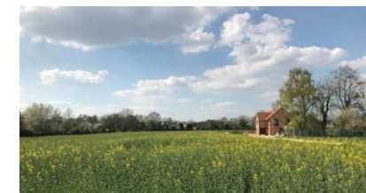
Perception depuis l'extrémité Nord Ouest, rue du Puits Cormier.
