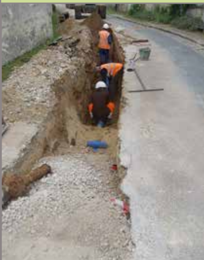
Travaux eau potable Boissy-aux-Cailles
