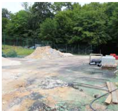
Chantier à novembre 2018
