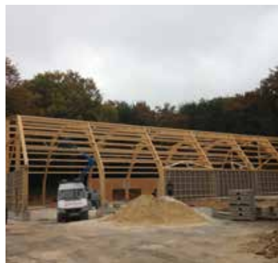
pose de la charpente
