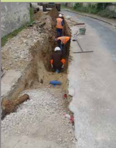
Travaux eau potable Boissy-aux-Cailles
