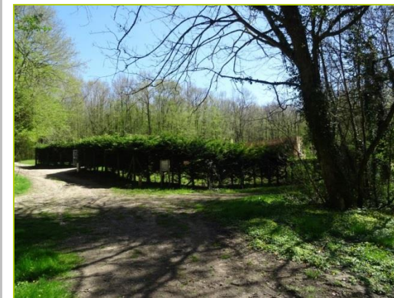
La station d'épuration dans le Bois Seigneur (Source : commune)
