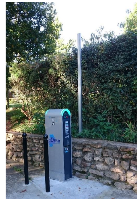
Borne de recharge des véhicules électriques
