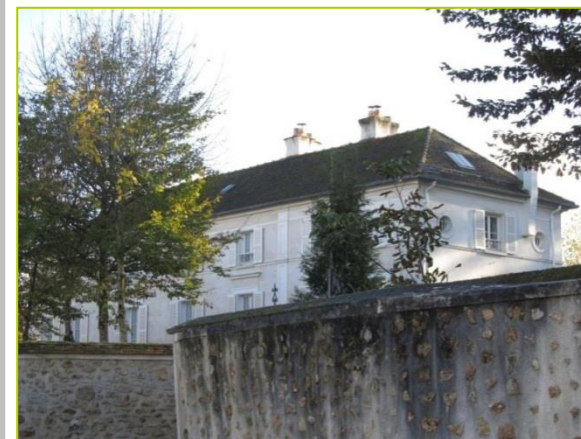
1. La maison de maître de Brinville depuis la rue des Fontaines
