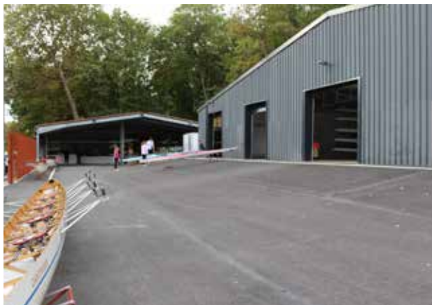
Base Nautique intercommunale de la Magdeleine à Samois-sur-Seine
