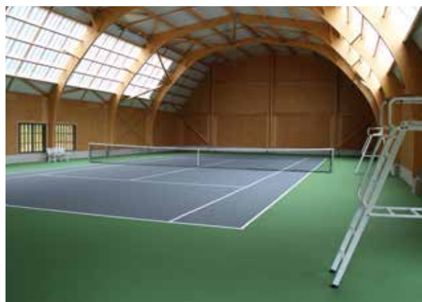
Tennis couvert intercommunal à Bourron-Marlotte
