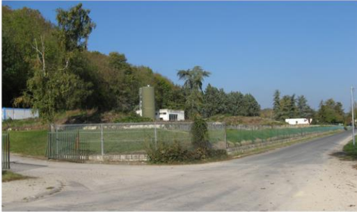
Station d'épuration de Valvins
