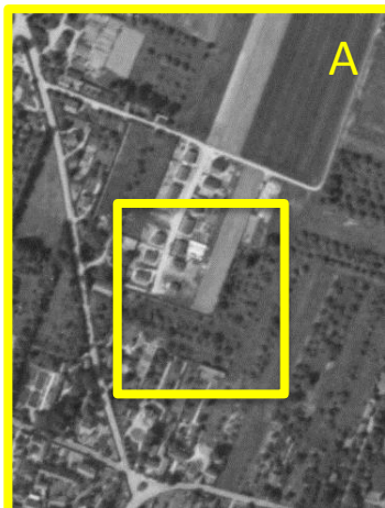
Lotissement du Grand Cléau. Photo aérienne 1961
