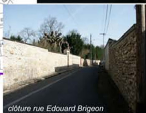
clôture rue Edouard Brigeon
