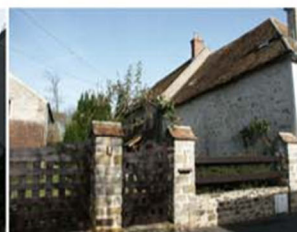
clôture rue Edouard Brigeon
