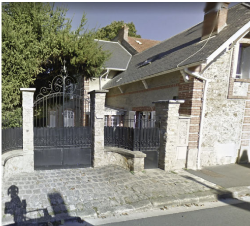
Villa, 81 avenue du Maréchal Foch
