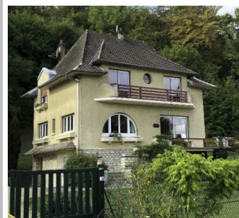
Villa des années 50, quai de la ruelle
