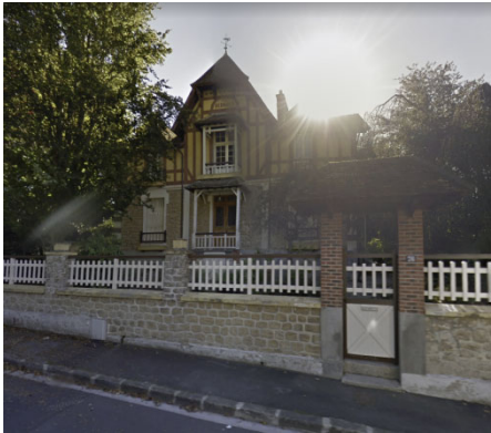
Villa, 76 avenue du Maréchal Foch
