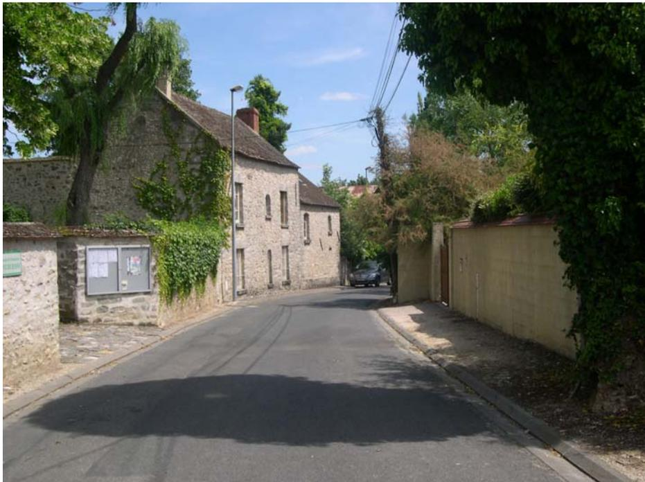
La maçonnerie à dominante de grès est caractéristique des maisons du pays de Bière. Les chaînes d'angle et les piédroits des baies sont formés de blocs taillés de forme allongée. Le reste des murs est constitué de moellons de grès et de meulière jointoyés au mortier de chaux ocré. Les pourtours des baies sont grossièrement taillés et habillés de bandeaux lissés de faible saillie. Les corniches sont constituées de simples bandeaux saillants
