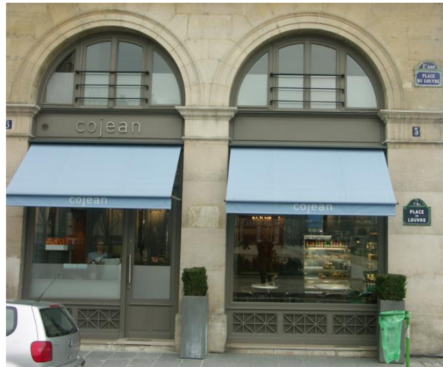
Exemple de prise en compte de l'architecture – source : UDAP77
