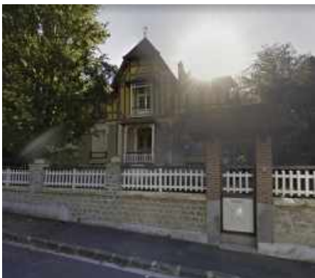
Villa, 76 avenue du Maréchal Foch
