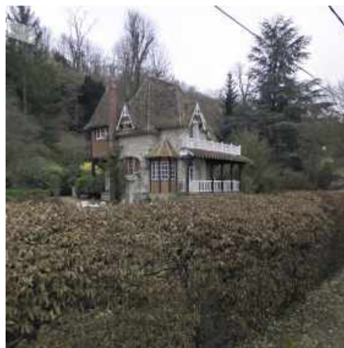
Villa, 47 quai de la ruelle
