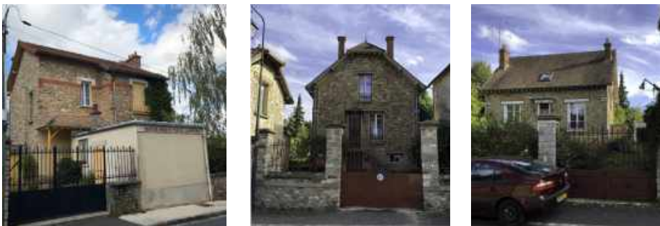
Pavillons de meulière dans le hameau de Bois-le-Roi.
