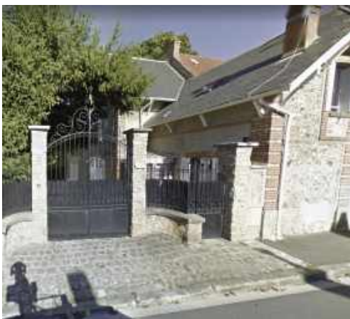
Villa, 81 avenue du Maréchal Foch
