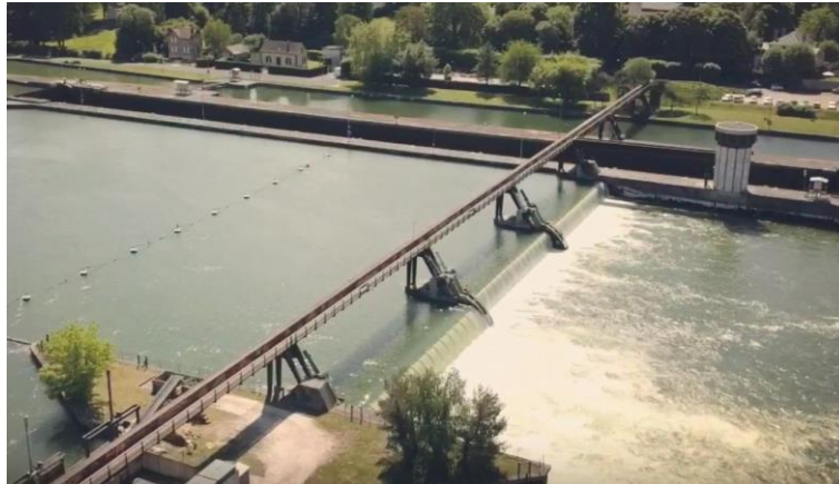
Figure 23 : Barrage hydroélectrique de Chartrettes
