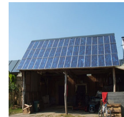
implantation sur une dépendance de type remise ou appentis
