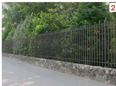
Clôture en serrurerie avec ou sans mur bahut
