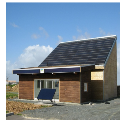
implantation sur une toiture mono-pente
