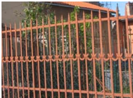
Exemples de serrureries anciennes
