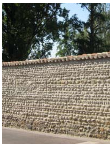
Mur en galets
