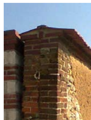
Mur en pisé, mur monolithe de terre tassée dans un coffrage
