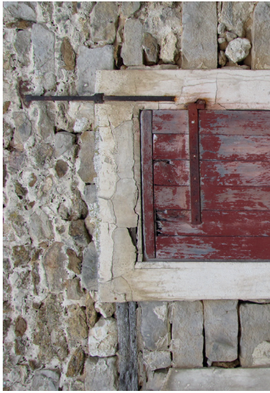
Les baies de la façade arrière ont été remaniées.
