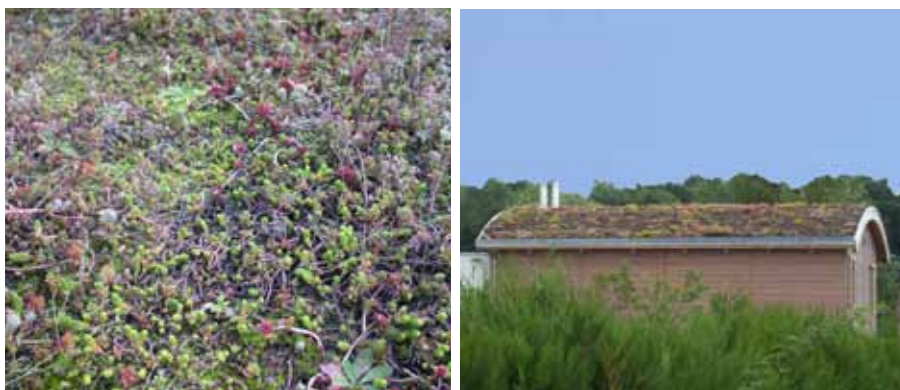
Toit végétalisé sur une maison d'habitation contemporaine.
