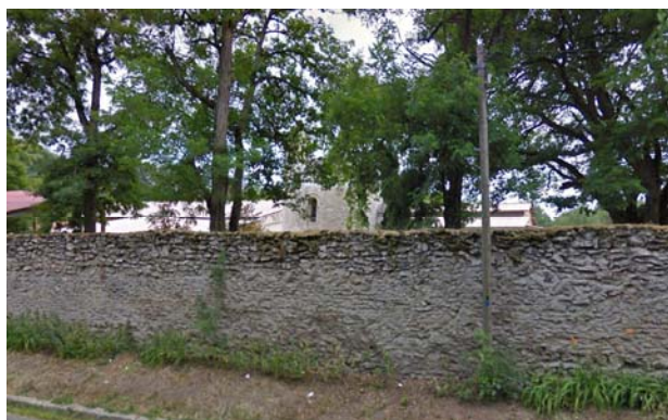
13 – Ensemble bâti et non bâti, RD64, au lieu-dit la « Roche Cassée », (mausolée circulaire, dénommé le « Tombeau des Chiens »)
