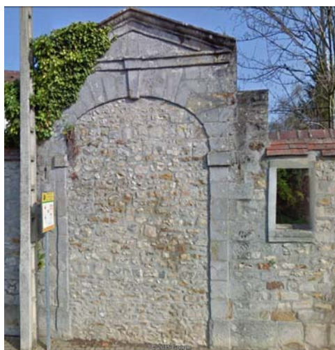
Vestige d'un porche rue des Tilleuls
