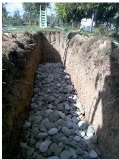
Fond de tranchée
