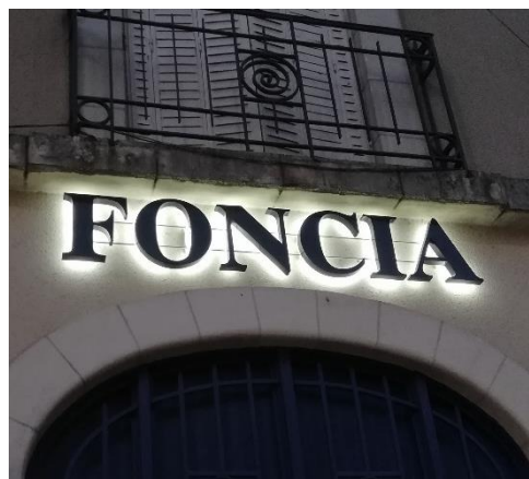
Lettres éclairantes sur caisson opaque et rétroéclairage – source : Even Conseil
