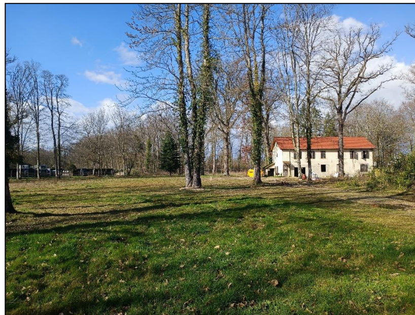
Photos 2, 3 & 4 : Vues du site, situation au 25/02/2022
