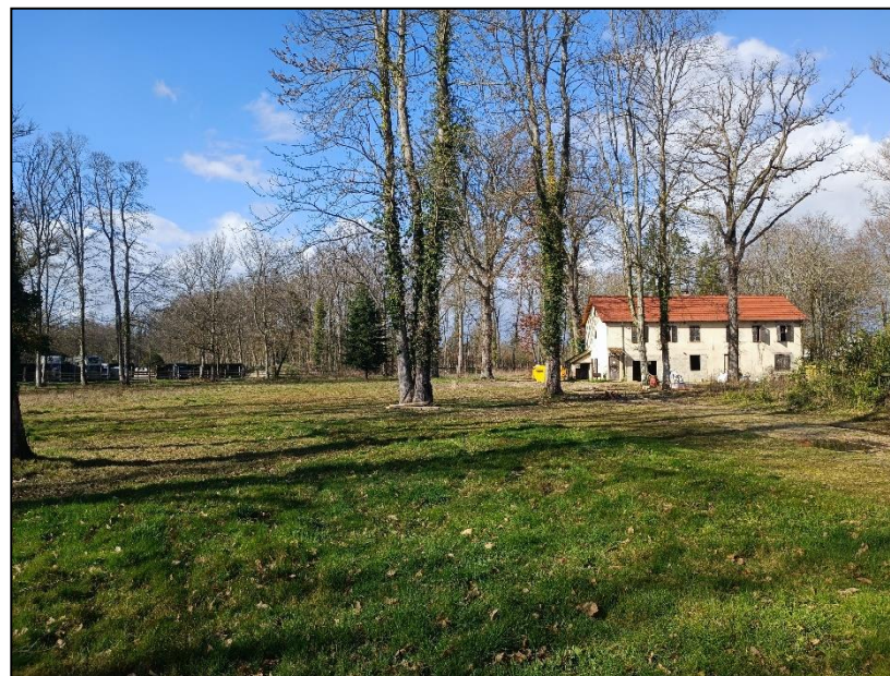
Photos 2, 3 & 4 : Vues du site, situation au 25/02/2022
