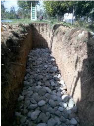
Fond de tranchée
