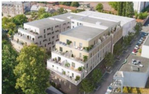
Résidence étudiante récemment construite rue Lagorsse
