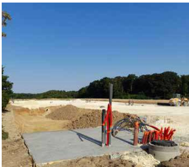
Travaux aire d'accueil des gens du voyage - Vulaines-sur-Seine
