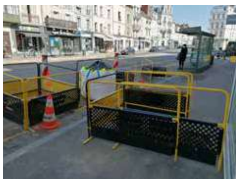
Travaux préalables Place de l'Étape
