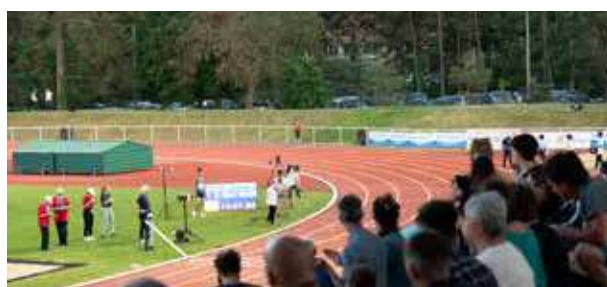
Travaux éclairages et piste d'athlétisme - Stade Philippe Mahut - Fontainebleau
