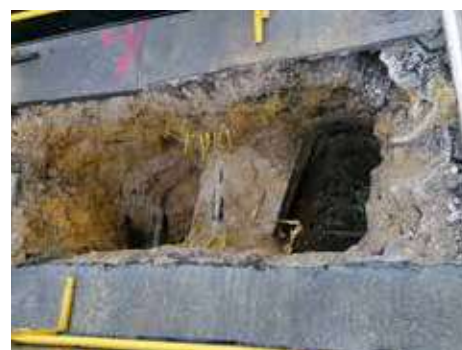
Travaux préalables Place de l'Étape
