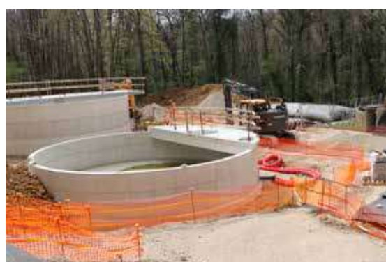
Construction de la STEP de Saint-Sauveur-sur-École
