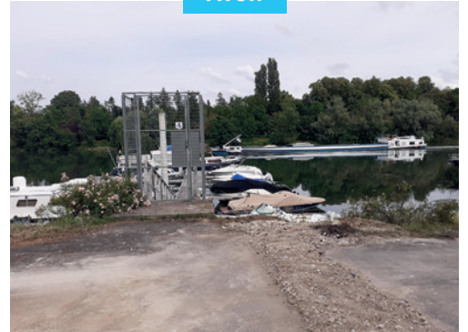
Travaux préparatoires au Port de Valvins juillet 2023
