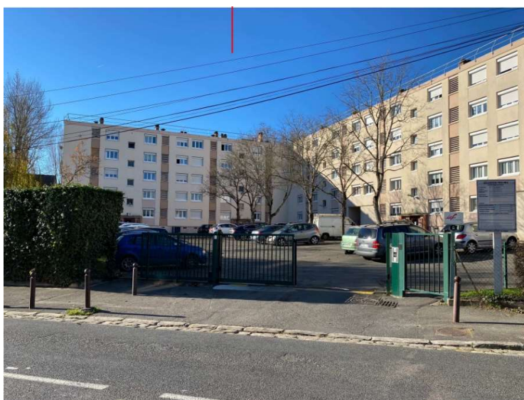
Propriété ICF Habitat La Sablière Route de Samois à Avon
