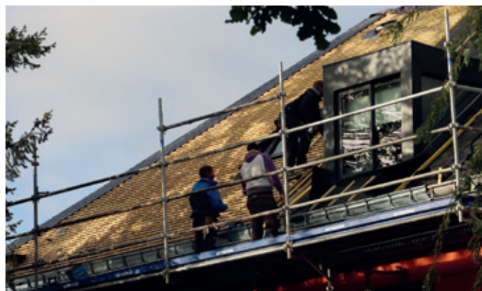
◆ Deuxième tranche de réfection du toit du bâtiment Stop & work à Fontainebleau Coût : 143 000€ HT pour 895m 2 de toiture en totalité
