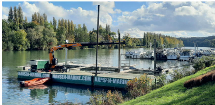
Ponçage et dépose des pannes 3 et 4
