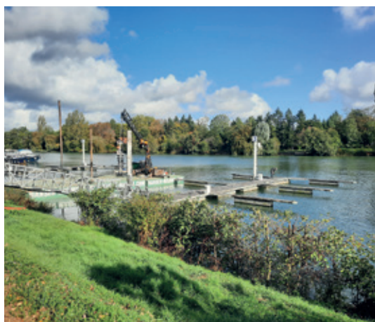
Livraison des nouveaux pannes 3 et 4
