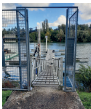
Installation des nouvelles portes et pannes 3, 4 et 5
