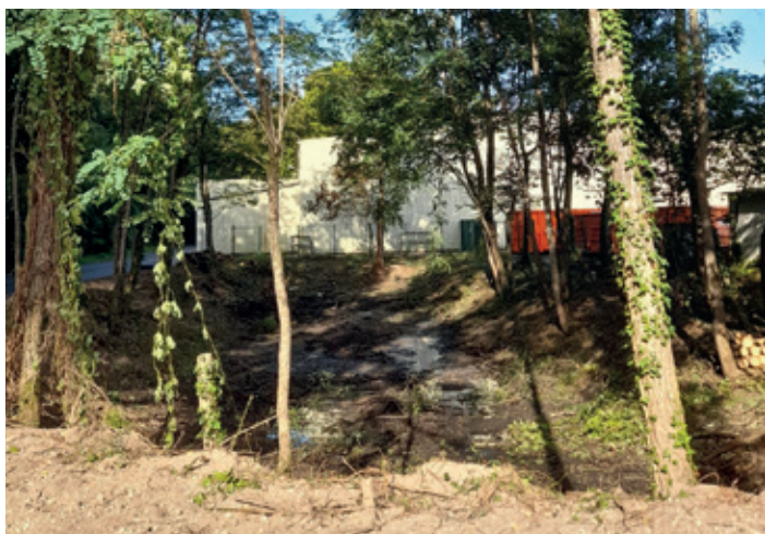
◆ Bassin pour eaux pluviales – Parc d'activités de Bois-le-Roi Curage du bassin, pose de clôture, coût : 18 000€ HT
