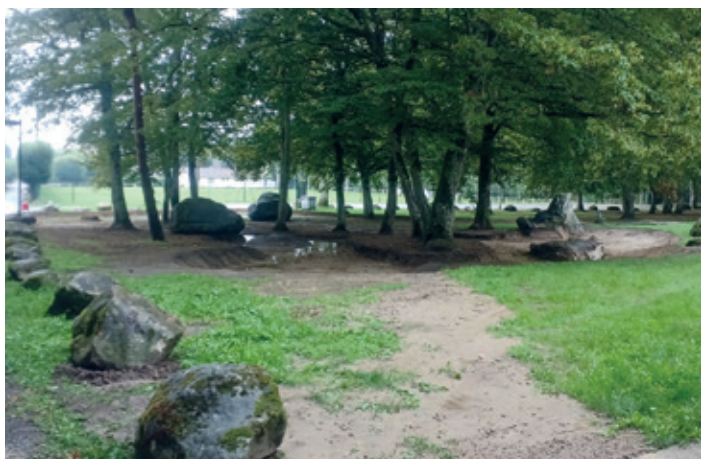
◆ Bassin d'infiltration des eaux pluviales – Gymnase André Poirier à Bourron-Marlotte Capacité d'infiltration d'une pluie vingtennale en trois heures soit 100 m 3 en fossés infiltrant - Coût 32 000€ HT
