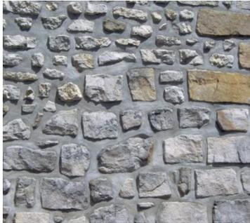
Exemple de jointoiement d'une maçonnerie ancienne en creux et au ciment interdit
