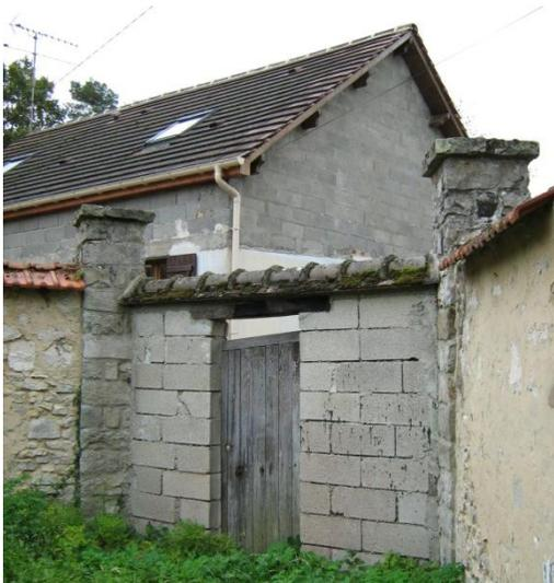
Exemple de maçonnerie apparente proscrire
