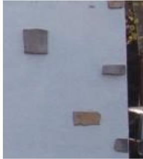
Exemple d'insertion de pierres dans l'enduit interdite
