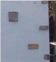
Exemple d'insertion de pierres dans l'enduit interdite
