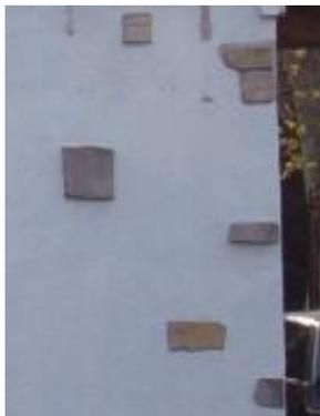
Exemple d'insertion de pierres dans l'enduit interdite
