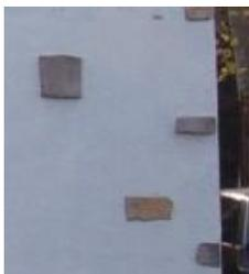
Exemple d'insertion de pierres dans l'enduit interdite
