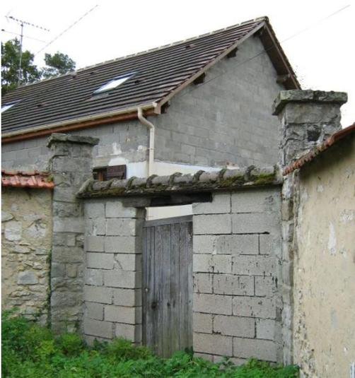
Exemple de maçonnerie apparente proscrire
