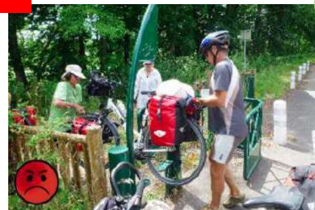
Dispositif contraignant sur voie verte Crédits photo : cerema.fr
