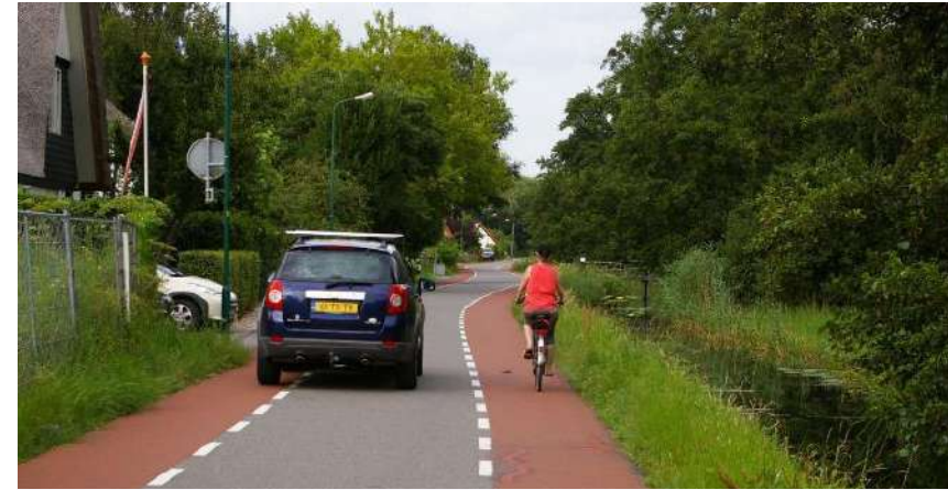
Chaussée à voie centrale banalisée avec différentes enrobées, Pays-Bas
