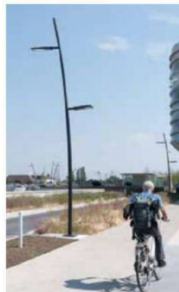
Emplacement adéquat éclairage
