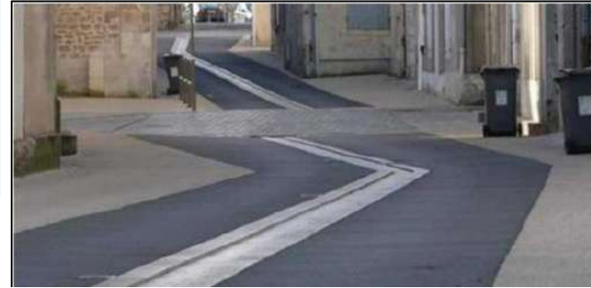
Intersection marquée par un revêtement en pavés dans une zone de rencontre – Ville de Niort.
